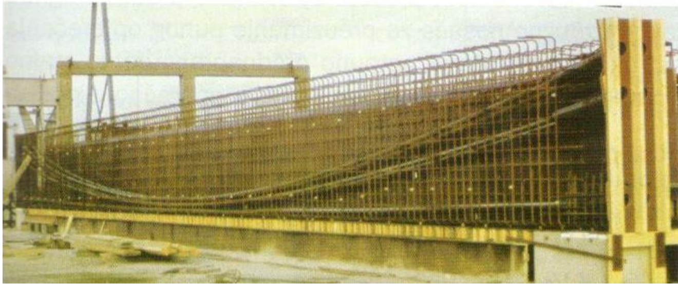
Slika 4.38 Armatura i kablovi armirano betonskog
